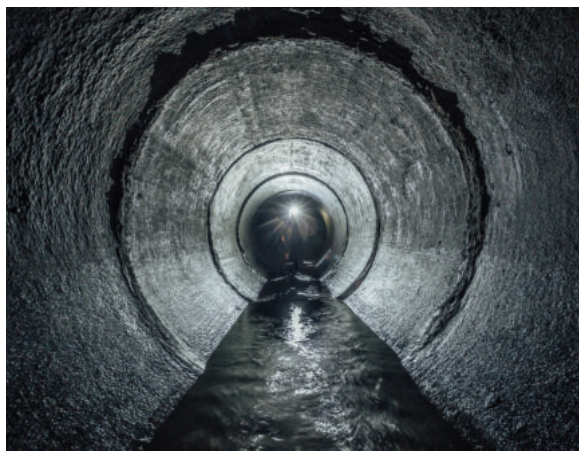
Vista interior de una alcantarilla (Fuente: Mulderphoto |stockadobe.com)
