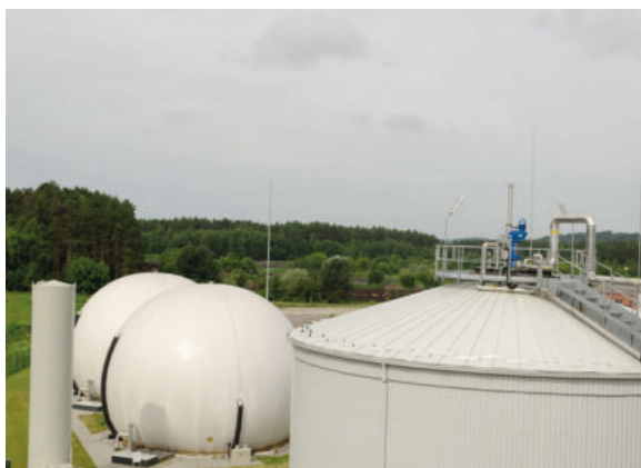
Planta de biogás con reactor de fermentación y tanques externos de almacenamiento de gas (Fuente: sauletas | stock.adobe.com)
