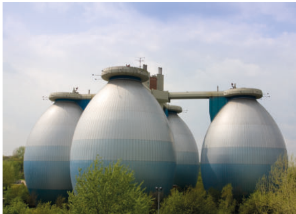
Planta de tratamiento de aguas residuales con torres de digestión (Fuente: Arnd Drifte | stock.adobe.com)
