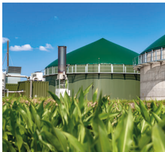
Planta de biogás
