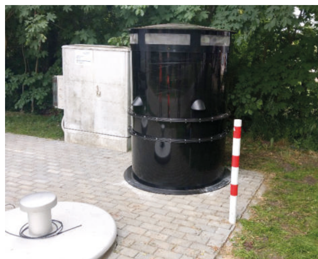
Filtro para remoção de odores do ar de exaustão de um poço de esgoto (Fonte: HeGo Biotec GmbH)
