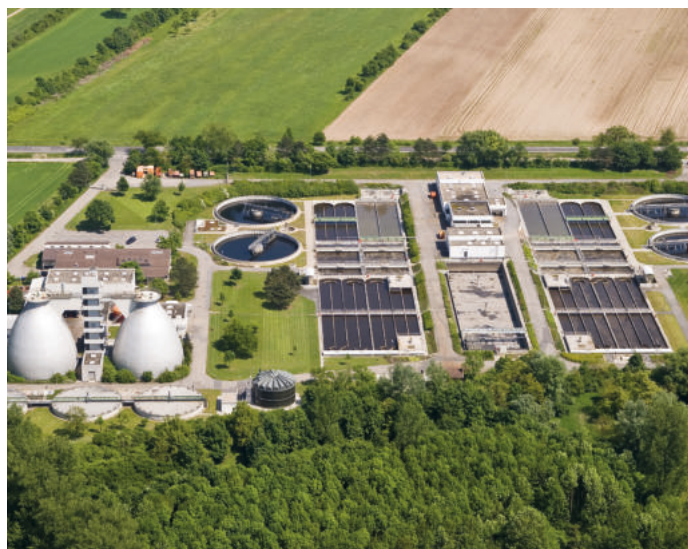
Estação de tratamento de águas residuais (fonte: Thomas Leiss | stock.adobe.com)
