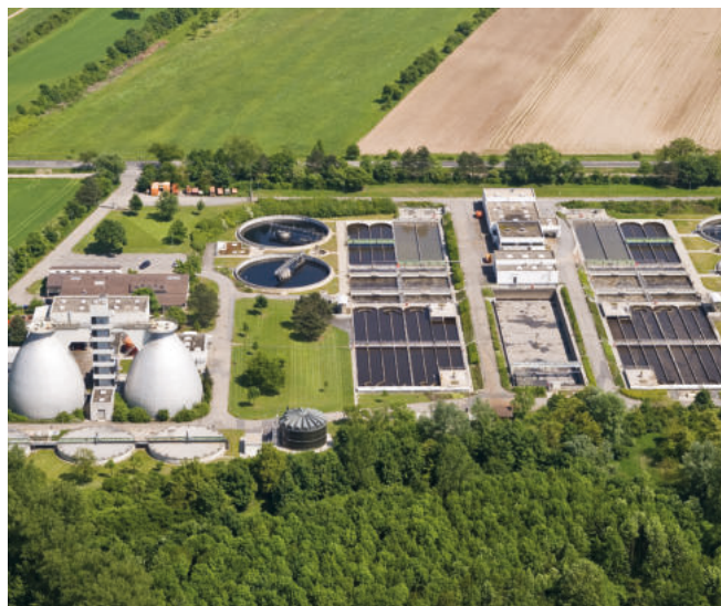
Estação de tratamento de esgoto (Fonte: Thomas Leiss | stock.adobe.com)
