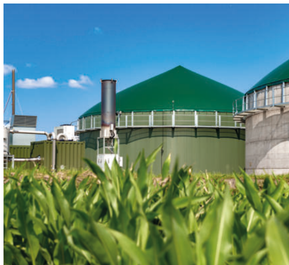
Usina de biogás agrícola
