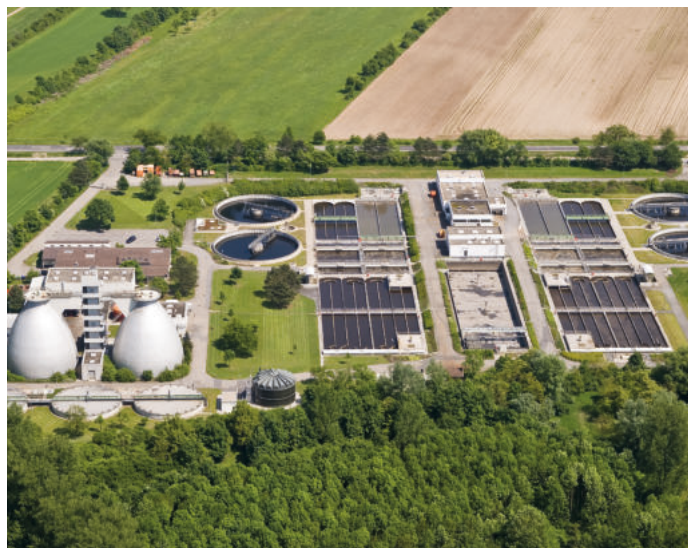
Kläranlage (Quelle: Thomas Leiss | stock.adobe.com)
