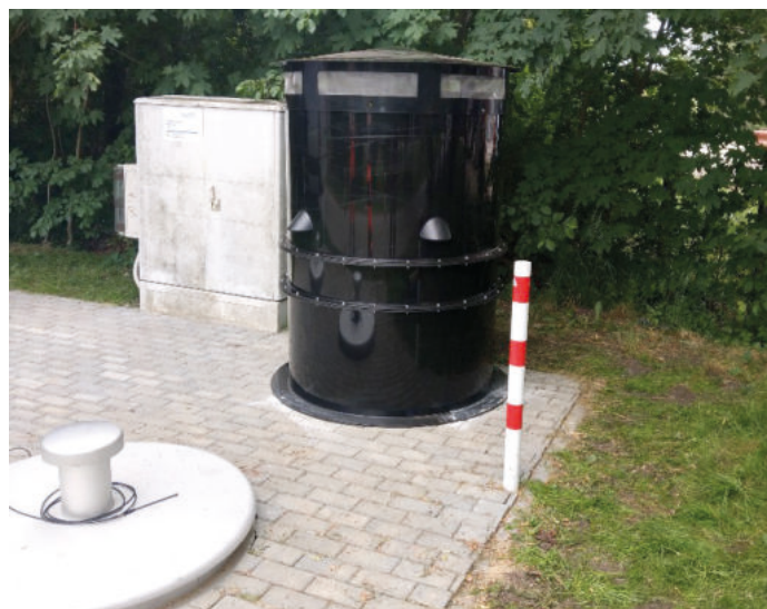
Filter zur Geruchsentsorgung von Abluft aus dem Kanalschacht (Quelle: HeGo Biotec GmbH)
