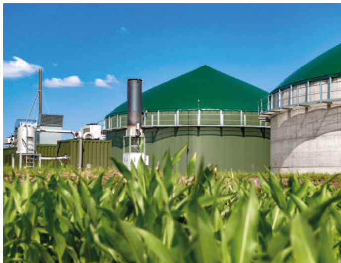
Biogasanlage (Quelle: Wolfgang Jargstorff | stock.adobe.com)
