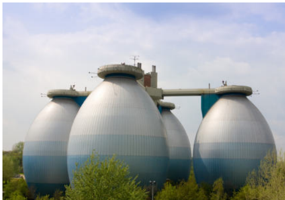
Kläranlage mit Faultürmen (Quelle: Arnd Drifte | stock.adobe.com)
