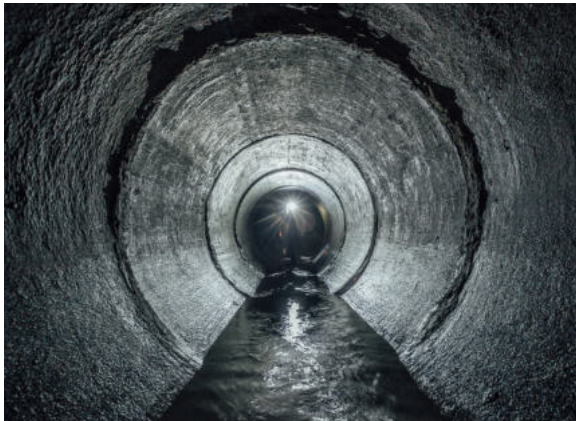
Innenansicht eines Abwasserkanals (Quelle: Mulderphoto|stock.adobe.com)
