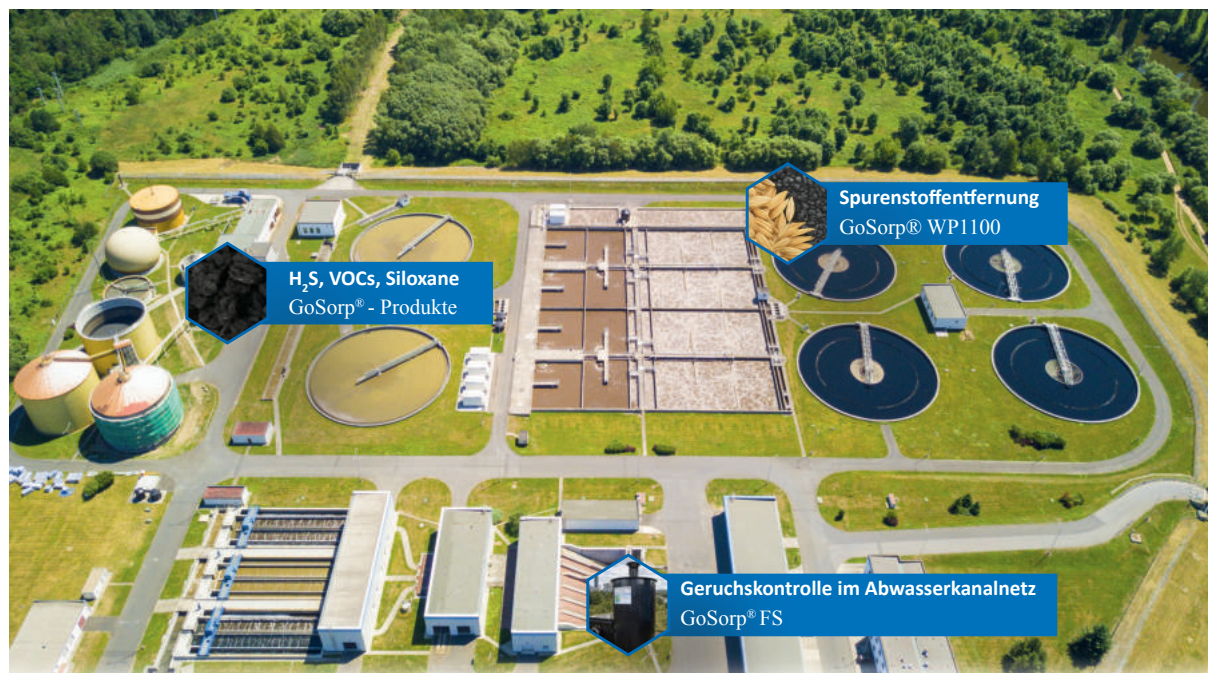
Luftaufnahme einer Kläranlage, individualisiert mit Einsatzmöglichkeiten von aktivkohlebasierten Produkten der HeGo Biotec GmbH Quelle: peterj|stock.adobe.com)
