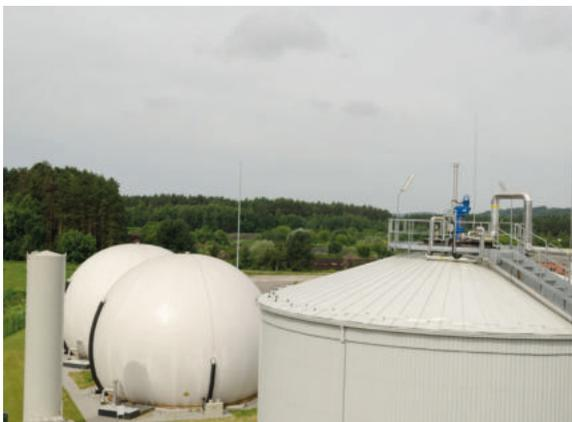
Biogasanlage mit Gärreaktor und externen Gasspeichern (Quelle: sauletas | stock.adobe.com)
