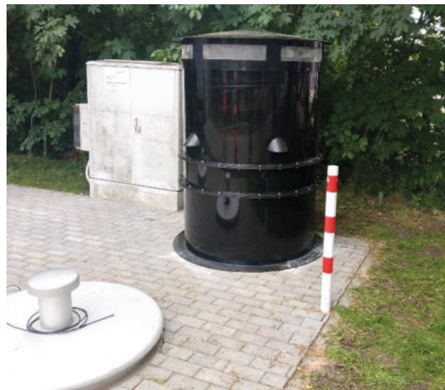
Filter zur Geruchsentfernung aus der Abluft eines Kanalschachtes
