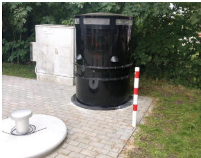
Filter zur Geruchsentfernung von Abluft aus dem Kanalschacht
